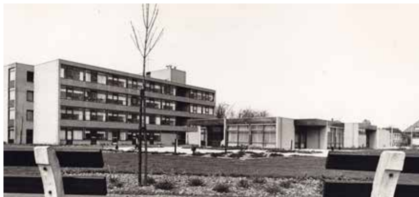
IN DE ZOMER VAN 1971 WERD DE BOUW VAN SINT MAARTEN IN DE GROE VOLTOOID. NU, RUIM 43 JAAR LATER, IS ER EEN SPLINTERIEUW WOONZORGCENTRUM VERREZEN AAN DE BEUKENSTRAAT EN WORDT HET OUDE GEBOUW GESLOOPT
